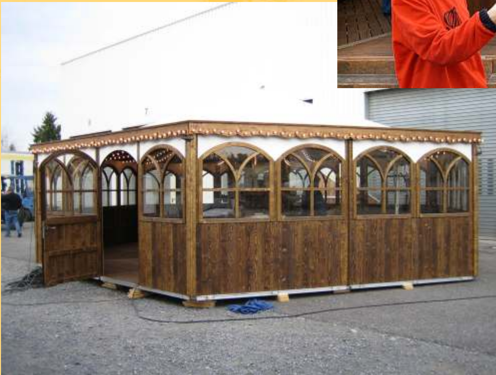
Während des Umbaus beim Soester Wagenbau
